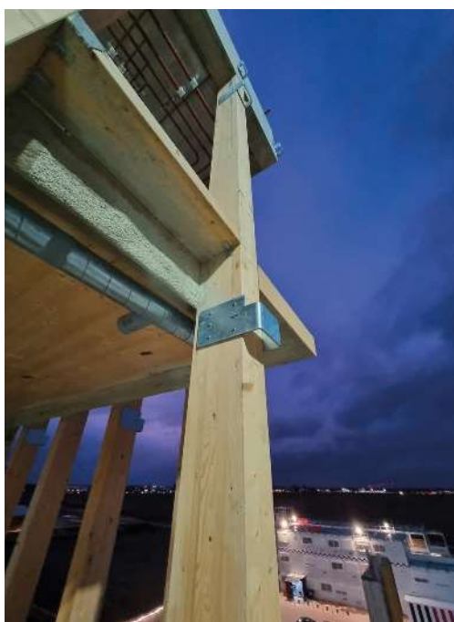
◀ Patte d'accroche d'un mur-rideau sur une ossature à base de bois.
