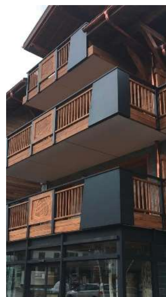
Le garde-corps intégrant des matériaux biosourcés devraient gagner en importance.
