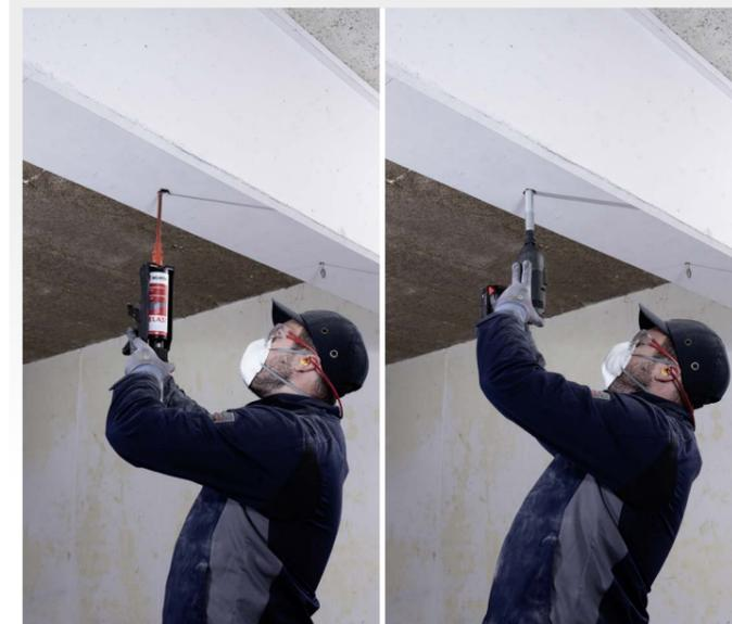
Instructions d'installation : injection du mortier et installation de la vis
