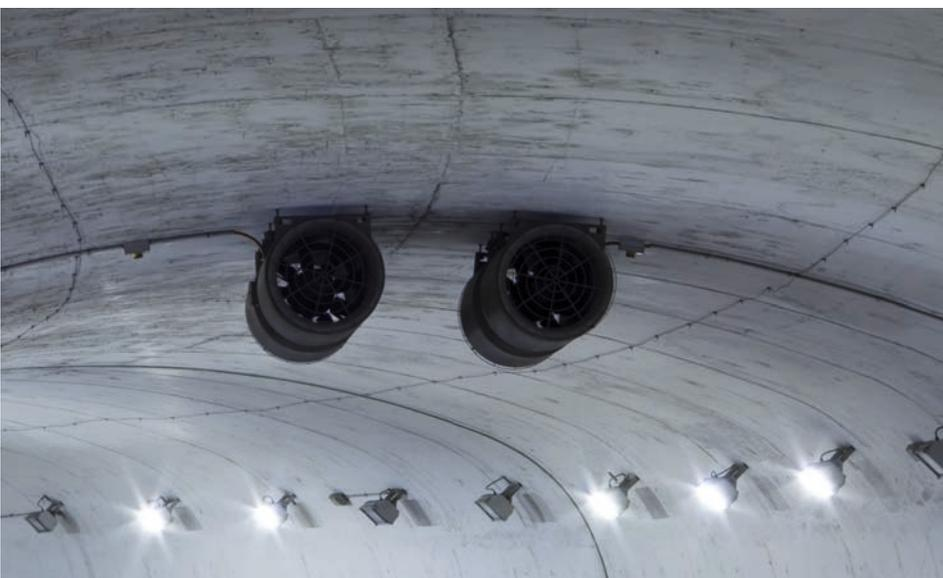
La circulation des trains et camions dans les tunnels induit des charges de fatigue sur les fixations, notamment en termes de pression et dépression liée au vent. Des charges périodiques se répétant continuellement peuvent mener à la rupture par fatigue des ancrages. Cela peut se produire dès 10 000 cycles de chargement (avec de 10 cycles par jour, il y aura plus de 10 000 cycles en 3 ans).
