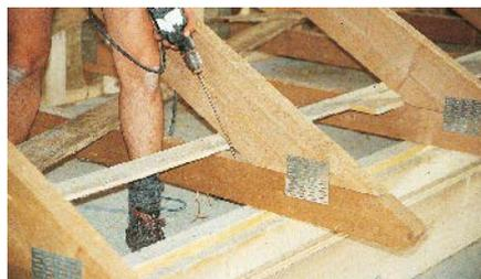
Fixation de pièces de bois pour fermettes, vérandas, charpentes...
